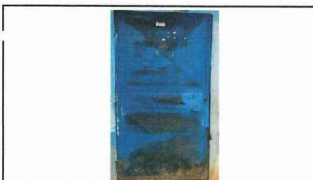
Foto 4: sustitucion de puerta de metal.
