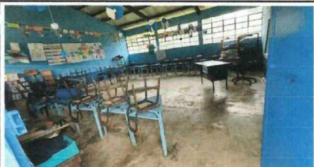
Foto 7: piso aula no 2: cambio de torta de cemento a piso cerámico para un ambiente mas agradable.
