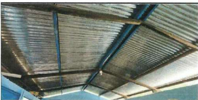
Foto 3: estructura a techo: sustitucion de estructura de techo por metal legitimo y de madera a metal.
