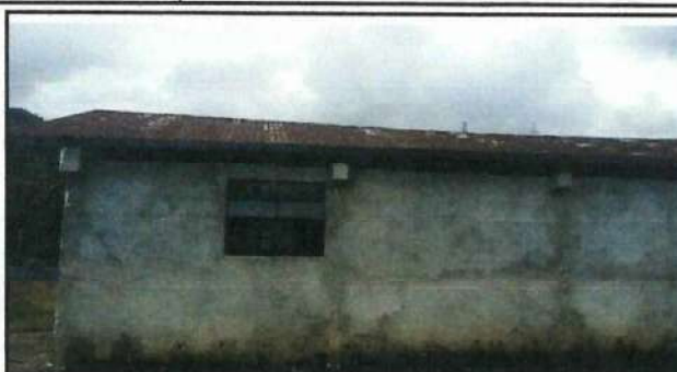
Foto 2: cubierta de lámina parte de atrás.
